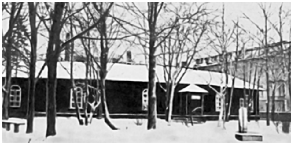
Здание Компасной обсерватории в Кронштадте
