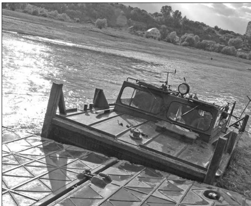
Пролеты моста монтирует катер-толкач
