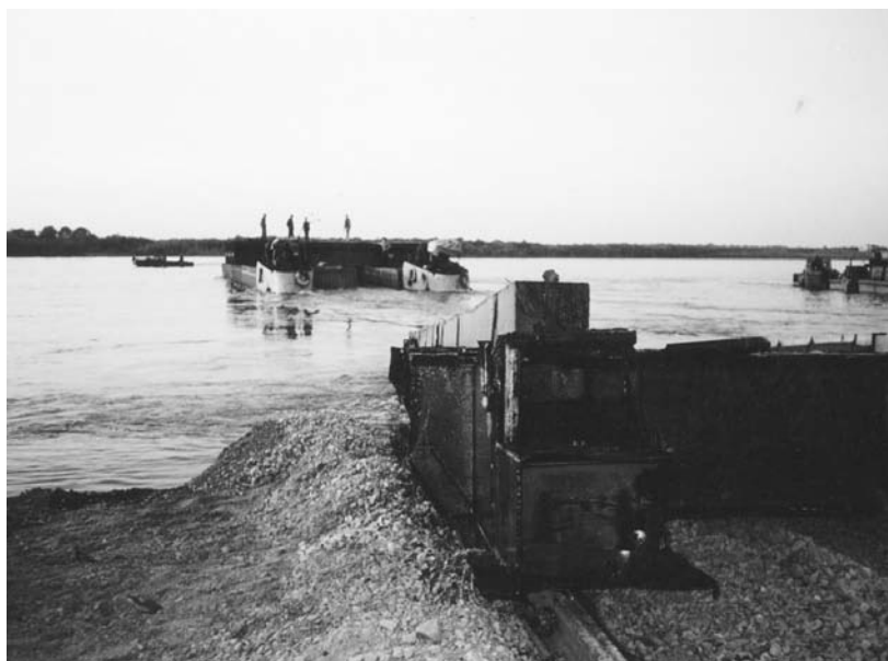
Наводка наплавного автодорожного моста через Амурскую протоку (г. Хабаровск).
