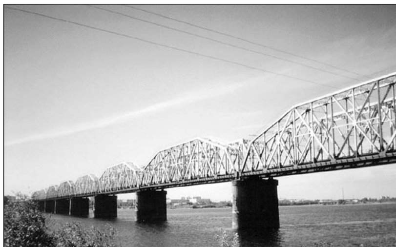
Мост через реку Кама (г. Пермь).
